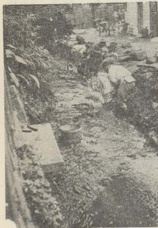
農地改良工事
