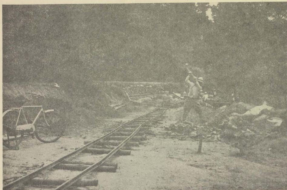
写真は東高安—恩智線の失対事業による工事
