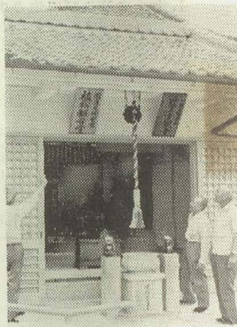
▲ 完成した植松観音堂
