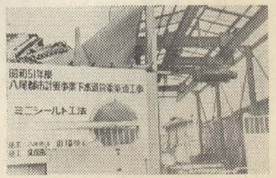
▲新工法による下水工事
